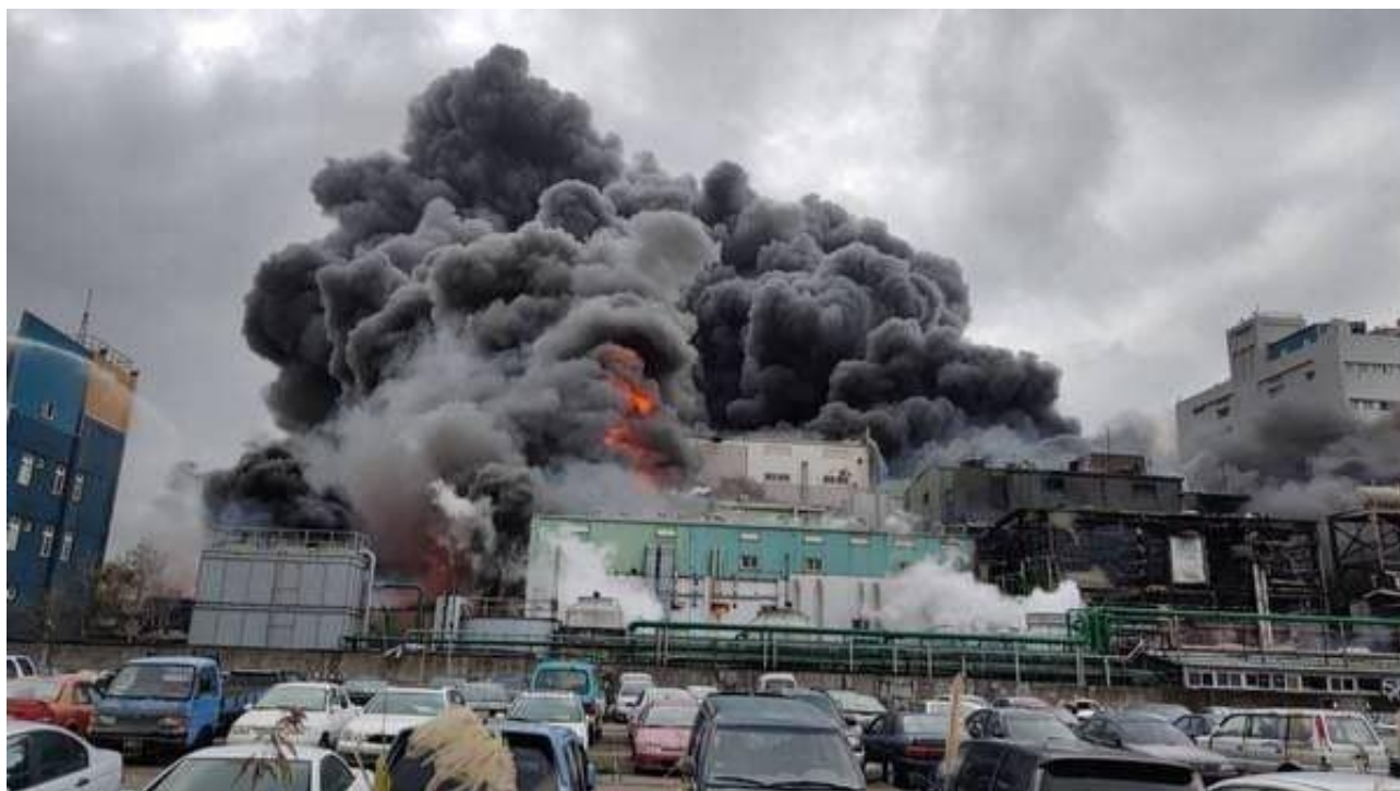
Usine pharmaceutique de la ville de Taoyuan, à Taiwan
